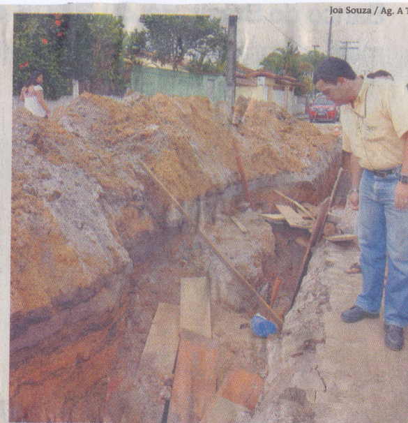
Inspetor Wellington de Novaes visitou obra da Embasa
