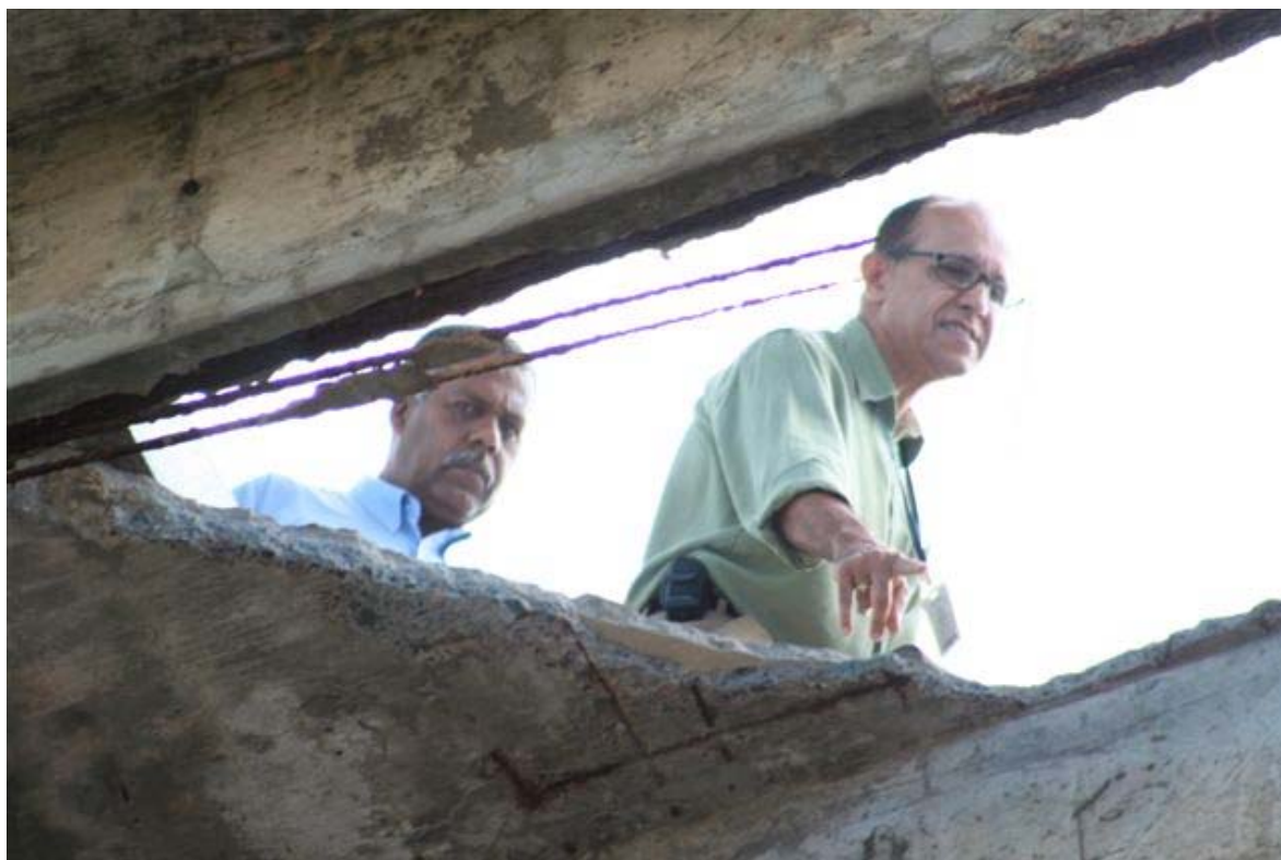
Foto 04 – Detalhe da ferragem da face inferior da viga, com seção reduzida.
