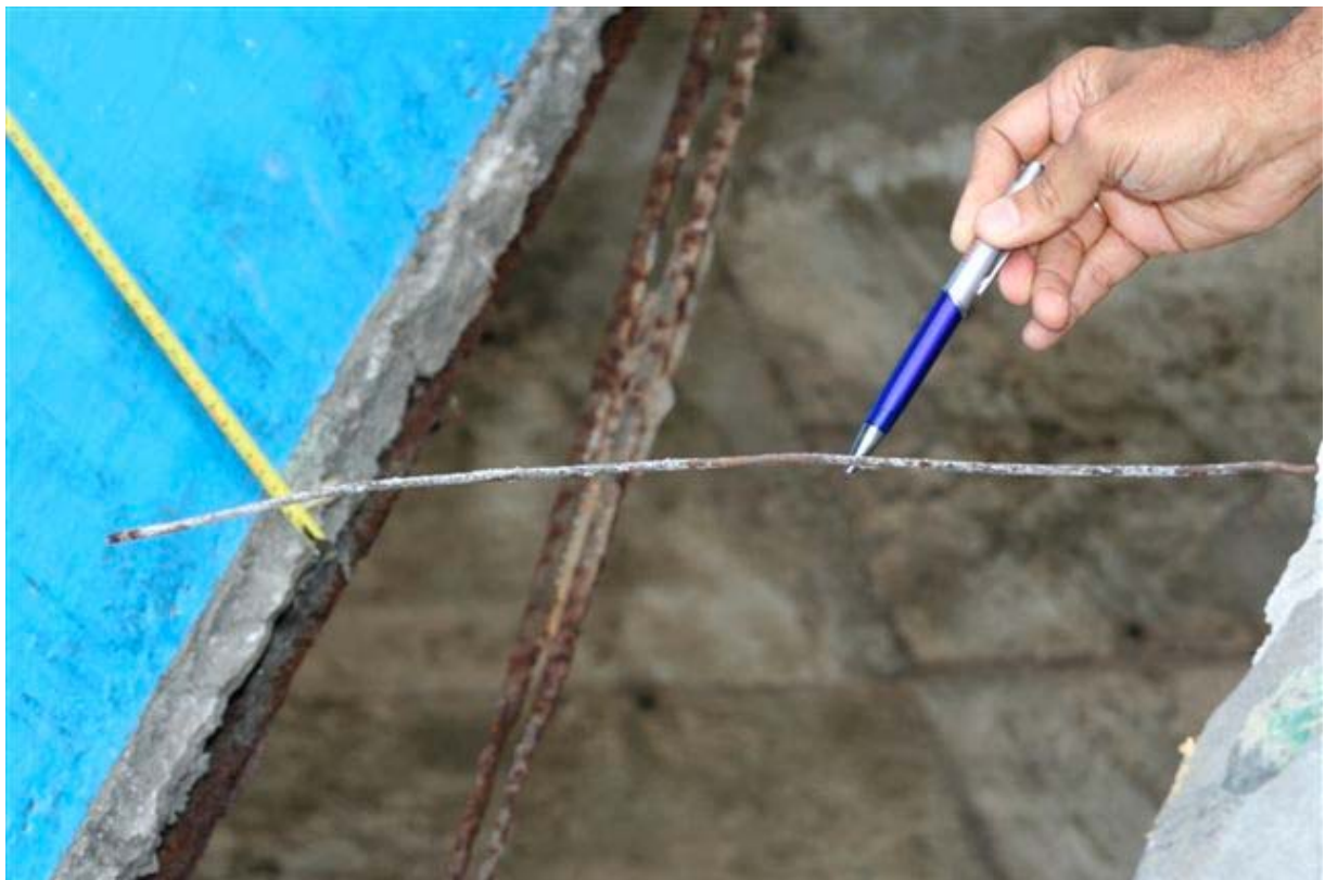
Foto 08 – Detalhe da armadura da laje.
