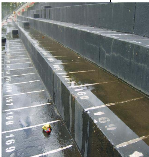
Fotos n.ºs 07 e 08: Arquibancadas com pontos de alagamentos, mostrando a deficiência da drenagem da mesma.
