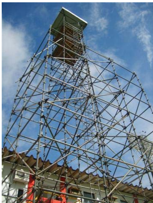
Fotos n.º 01 e 02: -Torres de observação montadas com estrutura metálica tubular com alturas de até 20 metros.
