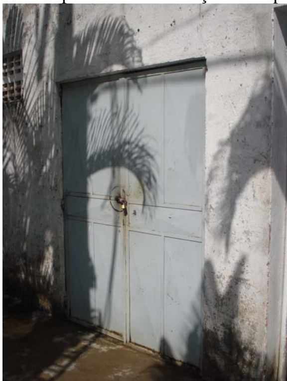
Fotos n.ºs 11 – Porta de acesso a subestação.
