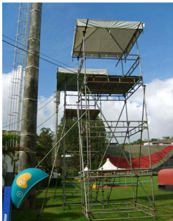
Fotos n.º 01 e 02: -Torres de observação montadas com estrutura metálica tubular com alturas de até 20 metros.
